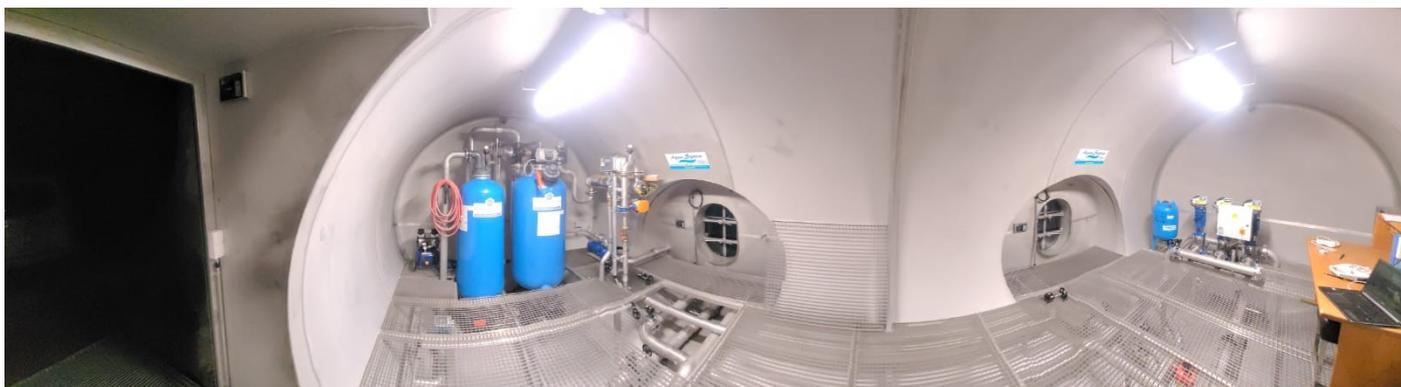
Die Bauarbeiten an der WVA sind mittlerweile fast zur Gänze abgeschlossen. (Asphaltierung und der Zaun am Hochbehälter fehlen noch). Bis auf eine kleine Wassermenge aus St.Martin versorgen wir uns nunmehr aus den eigenen Brunnen. Erfreulich ist die Wassertemperatur aus unseren Quellen mit ca 12 Grad Celsius. Mittlerweile ist man bei der Feineinstellung der Enteisungsanlage und der Brunnenzufuhr. Diese wird hervorragend von Fabian Witzmann bewerkstelligt.
